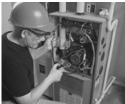
Рисунок 1 – Осмотр системы отопления, вентиляции и кондиционирования воздуха
